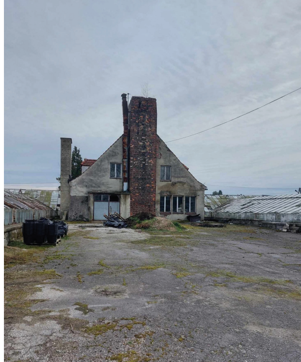
Pozostałości po kotłowni na terenie szklarni z 2024 r. Fot. Dominika Chowaniec
