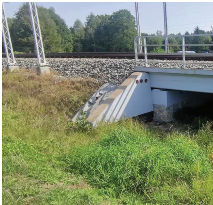
Fot. 5. Przepust pod torami, za którym działacze zostawiali kanapki więźniom, znajdujący się przy ul. Majer. Archiwum rodzinne, wyk. Róża Kopijas; 7.09.2024 r.
